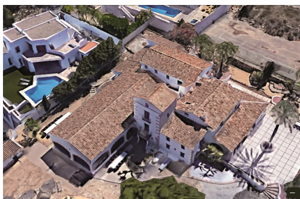
Vista general de la Casa dels Espinós (Google Earth)
