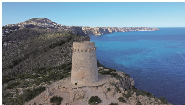
Vista frontal torre (estat previ)
