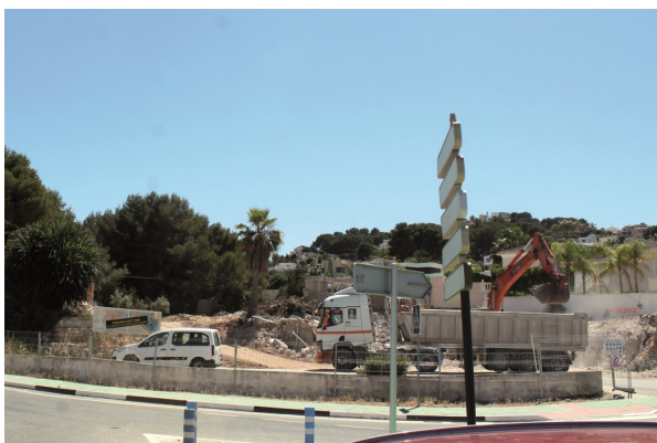
Solar buit i la casa enderrocada
