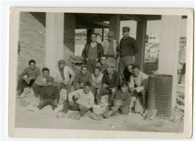
Apartaments “Las Viñas”, en obres
